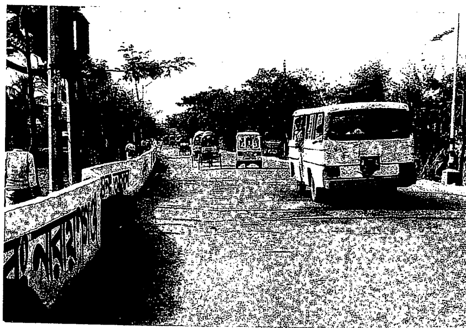
DND プロジェクト地域区域でのコンクリート製の洪水防御壁
