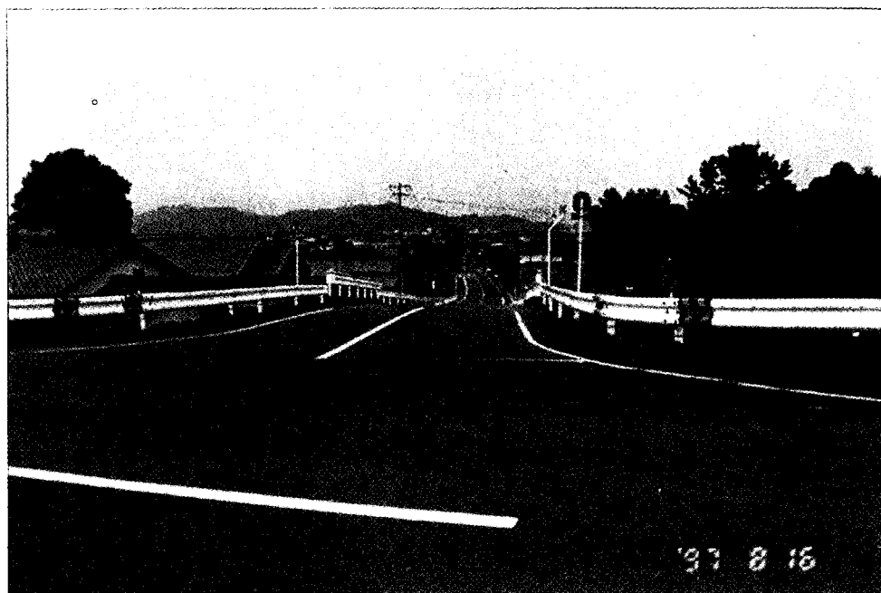
現場堤防上から那加町方面につながる三井街道を望む。
