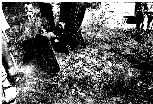
写真4.6 河原植物の堀削
