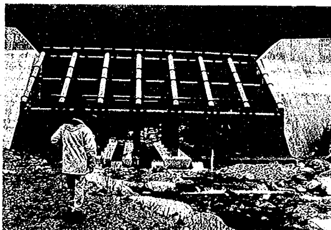
写真-2 透過型砂防ダムの事例
