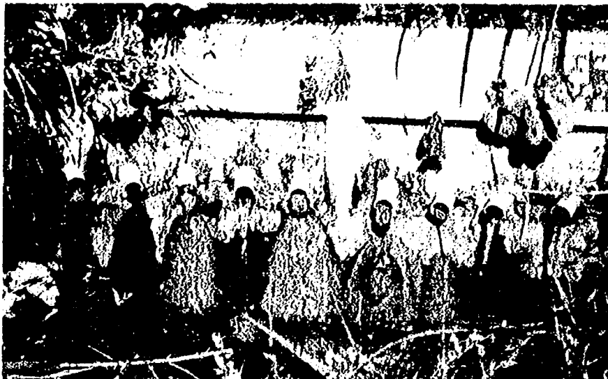
写真-1 横ボーリングのスライム付着状況（茶屋地区）
