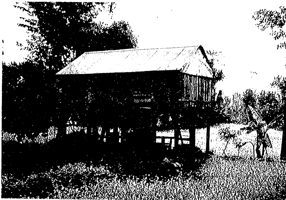
写真－１４ 高床式建物
