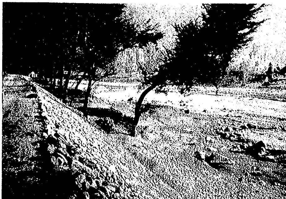
写真－8 水害後世銀融資により完成したLotha川堤防 融資により2年間で完成した高盛土（高さ7～8m） の連続堤。22kmの延長を有する
