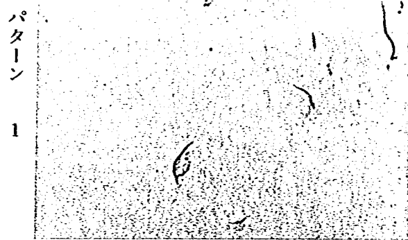
溶融亜鉛めっき鋼の劣化標準写真（われ） (10)
