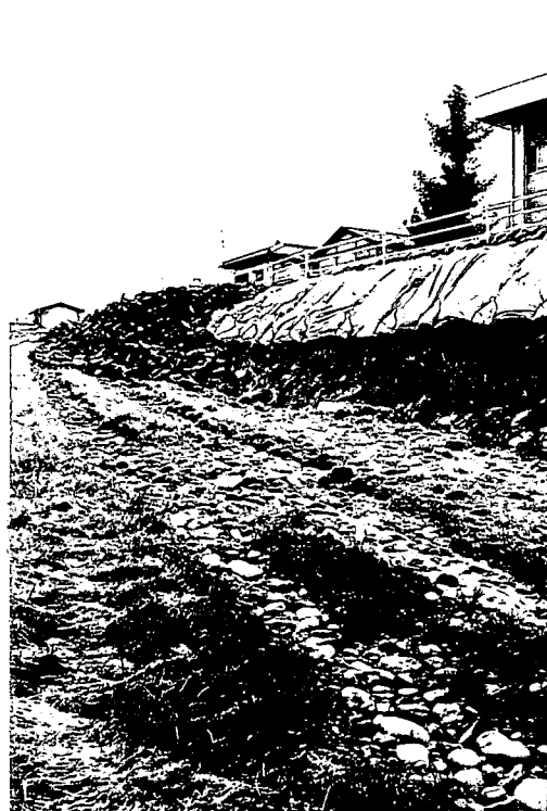
・写真 No. 20-2：洗掘箇所近景(捨石の投入)
