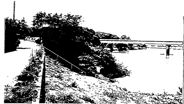
・写真 No. 25-1 : 堤防全景 (上流より望む)
