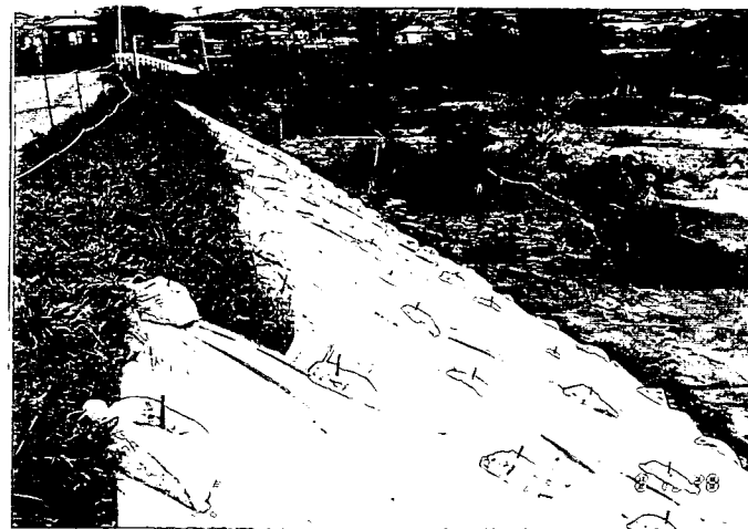
・写真 No. 19-2：洗掘部近景
