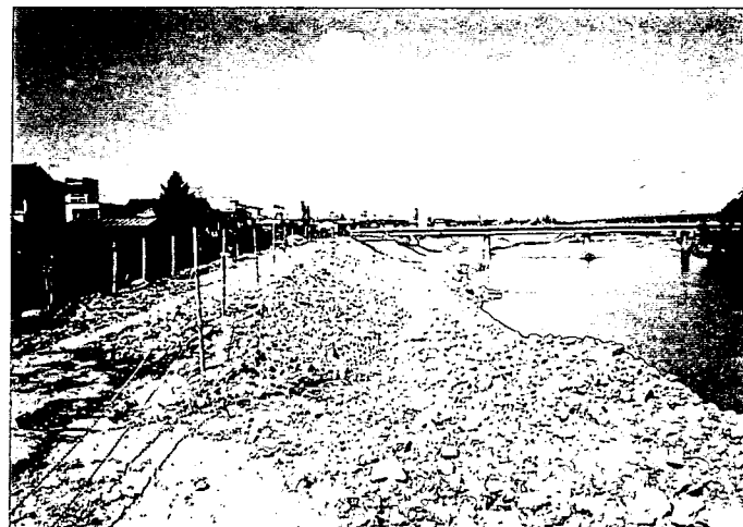
・写真 No. 35-2：堤防のり面全景（上流より望む）。
