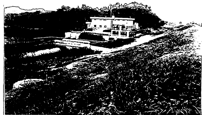
・写真 No. 2-1 : 堤防裏のり全景
