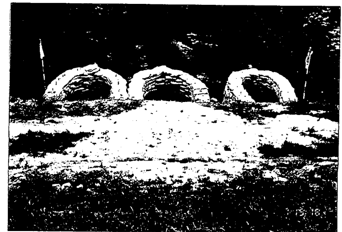
・写真 No.5-2: 月の輪工全景 (川裏)
