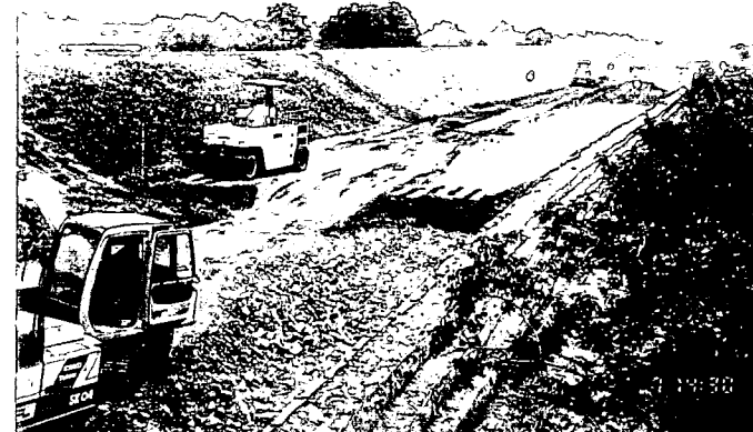
・写真 No. 3-1：堤防破のり全景
