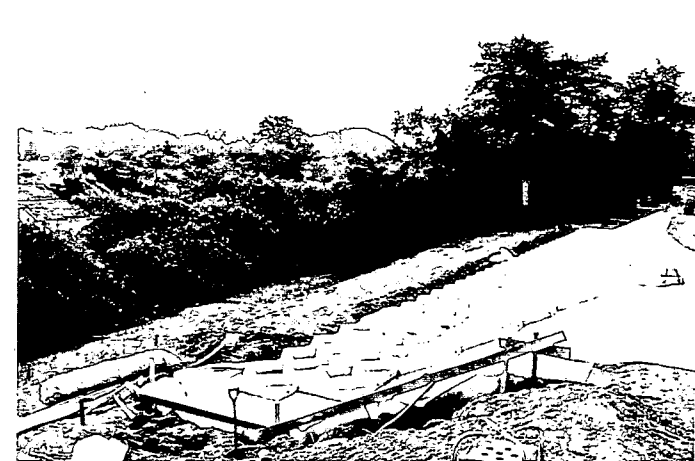
・写真 No. 14-1：復旧工事全景（川表）
