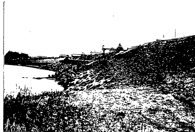
・写真 No. 35-1：堤防のり面全景（下流より望む）
