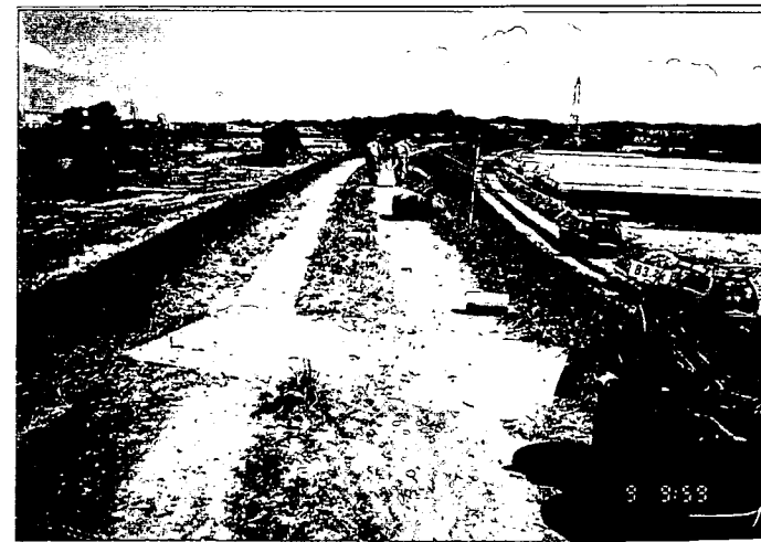
・写真 No. 24-2 : 堤防全景(下流より望む)
