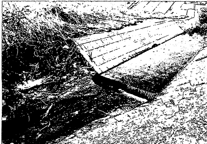
・写真 No. 10-1：樋管取り付け水路状況
