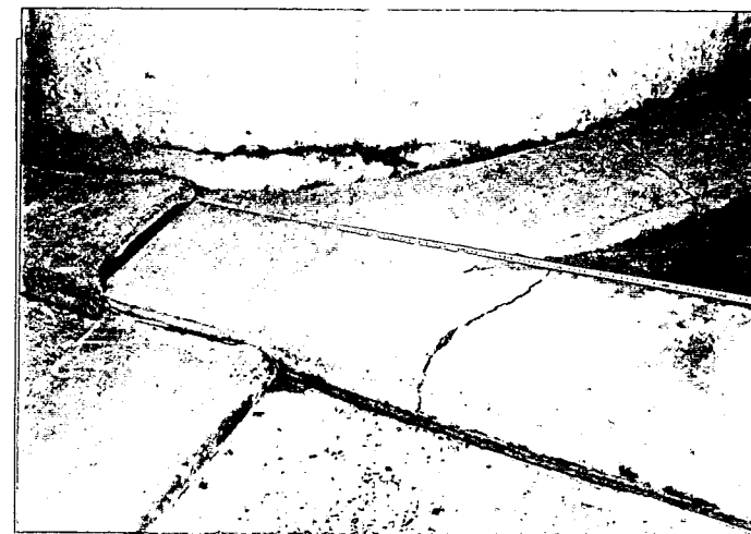
・写真 No. 34-2 : 平張りブロックのクラック
