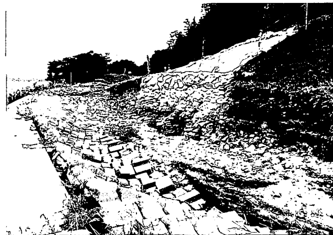
・写真 No. 8-2 : 被災箇所全景
