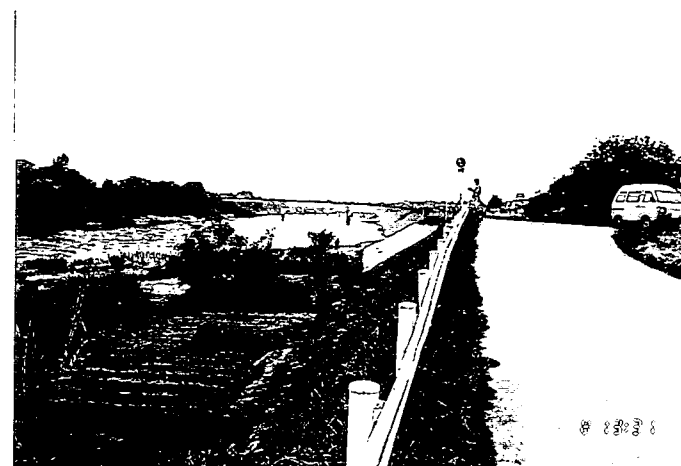
・写真 No. 19-3：被災箇所遠景
