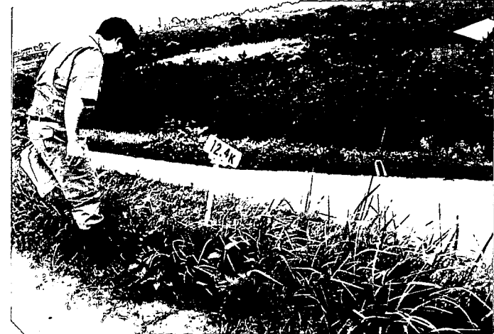
・写真 No. 6-1：堤防川裏のり全景
