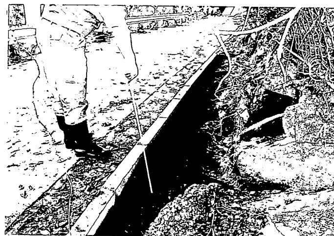
・写真 No. 18-3：路肩吸出し状況
