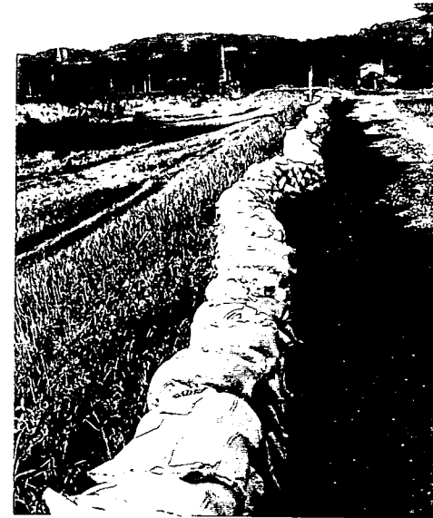
写真 No. 29-1 : 被災堤体全景(川表)
