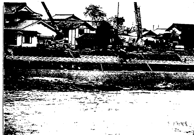
・写真 No. 1 1 - 3 : ＜緊④＞フトン籠(基礎)＋大型連接ブロックエ＋ジオテキスタイル
