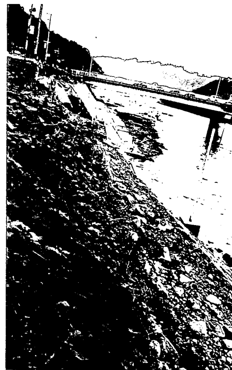
・写真 No. 12-1：のり面崩壊全景
