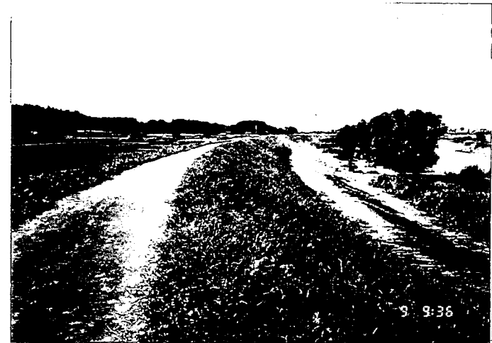
写真 No. 23-1：堤防全景(下流より望む)
