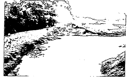
破堤後、盛土と連節ブロック張により復旧に入ろうとしたが再び増水となり中止
