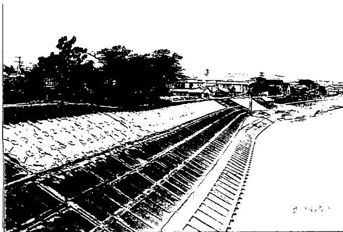
・写真 No. 20-1：川表のり面全景
