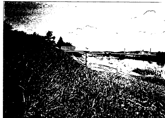
・写真 No. 32-1 : 川表全景(上流より望む)
