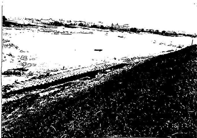
・写真 No. 8-1 : 堤防川表のり面全景
