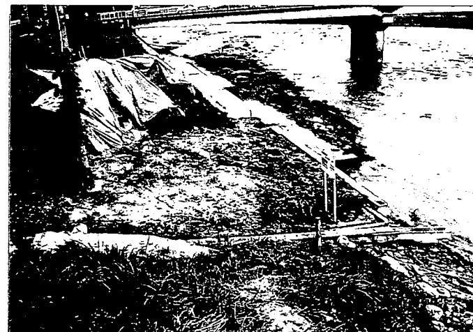
・写真 No. 12-2：のり面崩壊近景
