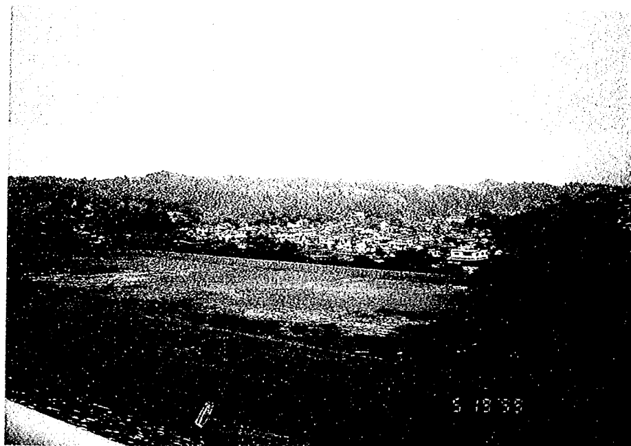
写真－２２ 堤体より下流側の市街地を望む
