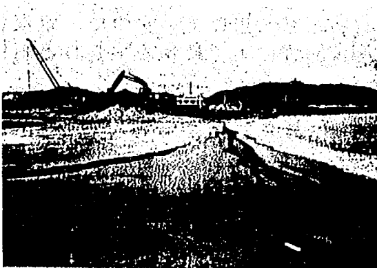
写真－３ 土砂の採取状況
