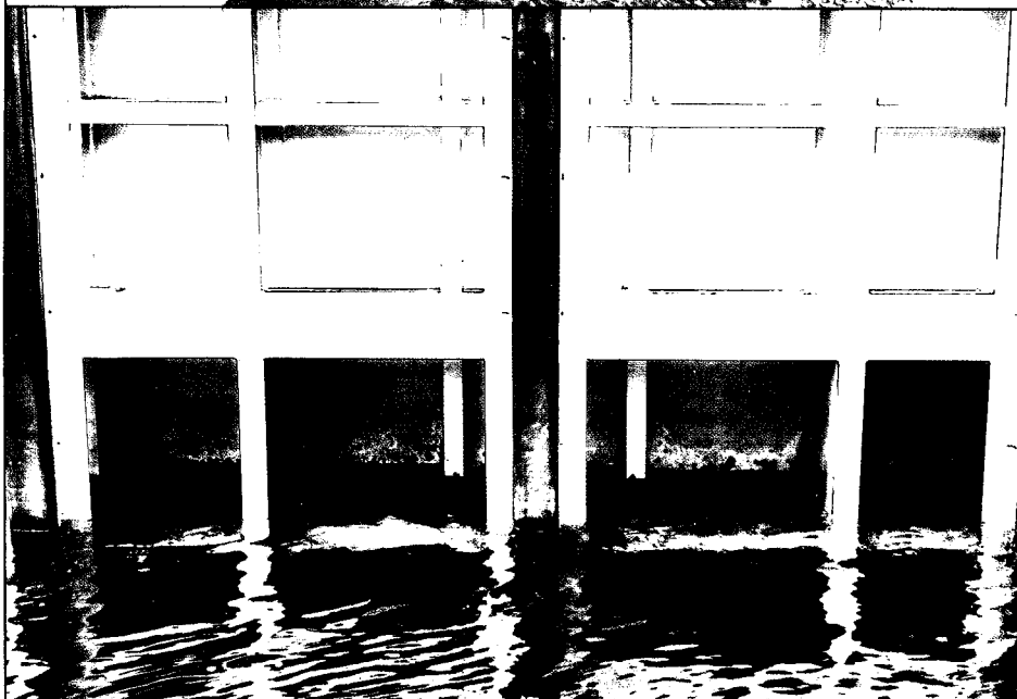
写真 14 三重県 深谷漁港 アルミ合金製マイターゲート 南側扉体
