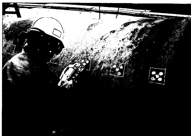
写真 1.4-2 ガードリング肉厚測定位置決め作業
