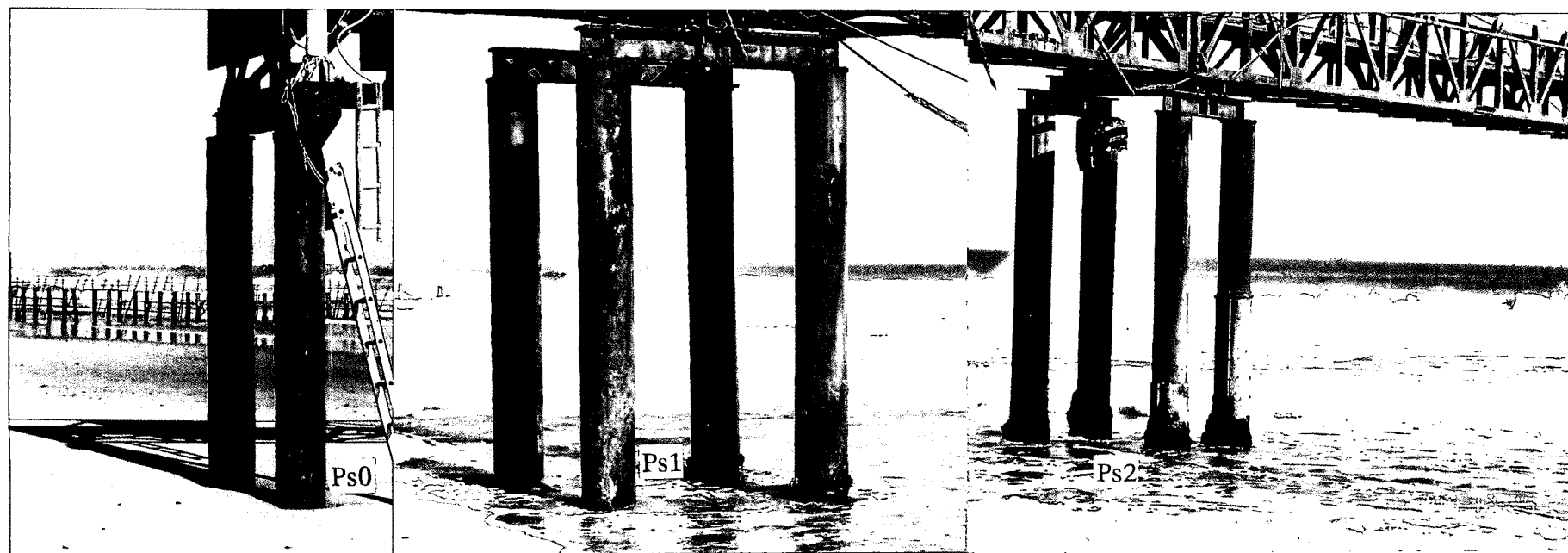
写真 1.2-1 観測用栈橋現況 (20 年経過)
