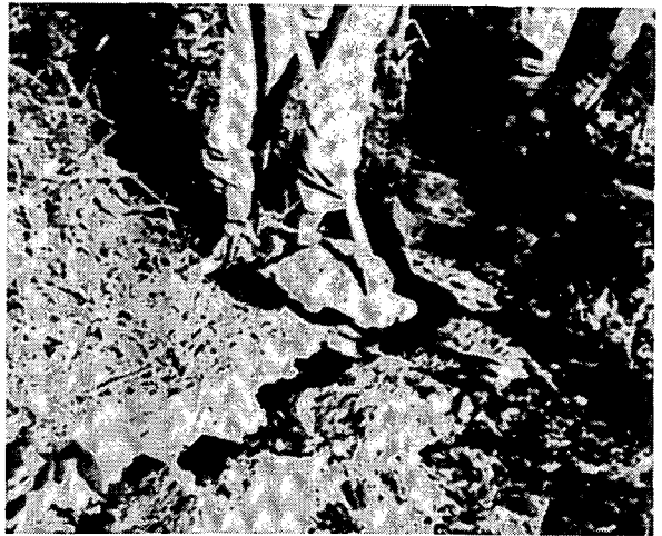
塵埃を除去したのち平鍬で芝を切取る
