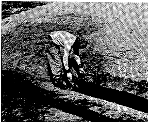
手釣にて張芝を一段並べる(段積苗工) 仕上施工
