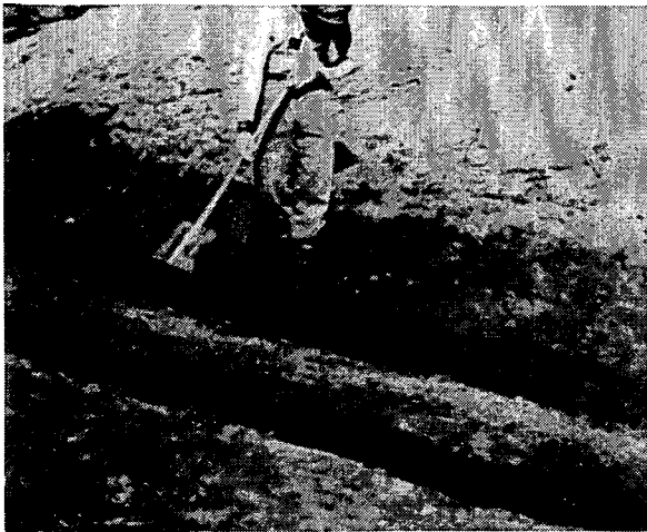
細土を踏締めながら土羽板で3～4分位の こう配にたきつける
