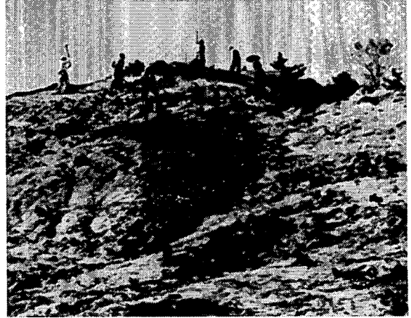
山腹ノリ切工
