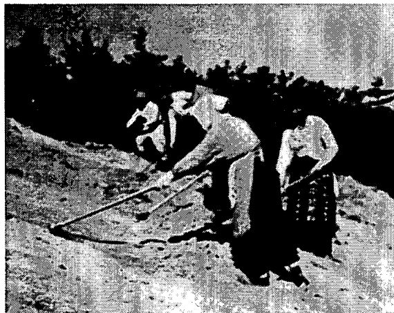
土砂は鋤簾でかき下す
