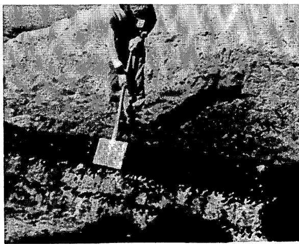
三段目を土羽板で締める
