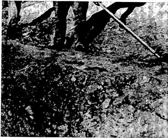
水平に幅20cm切込む
