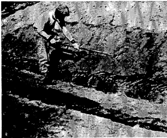
雑柴が敷き終ると二段目張芝を付けるため 細土を鋤簾でよせる
