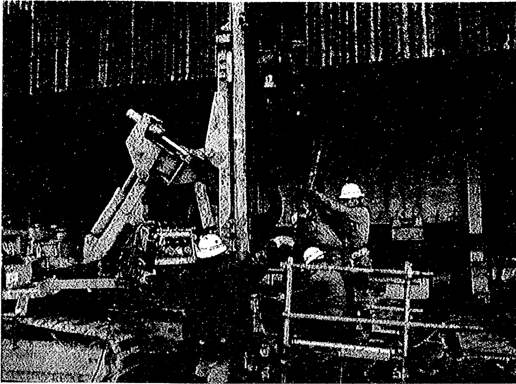
写真一付 2.5 鋼管再挿入状況
