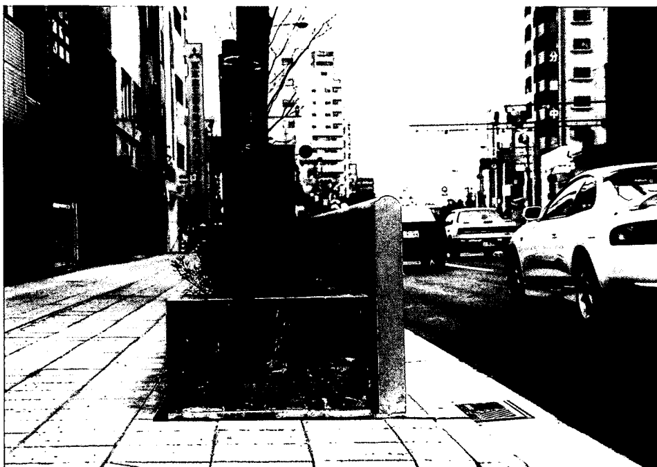
写真 3 - 2 パネルタイプ+植栽柵タイプの低層遮音壁（国道4号東京都足立区南千住）
