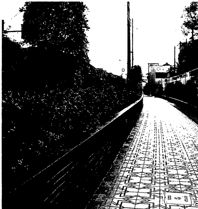
写真 3 - 1 植栽柵タイプの低層遮音壁（国道23号三重県四日市市）
