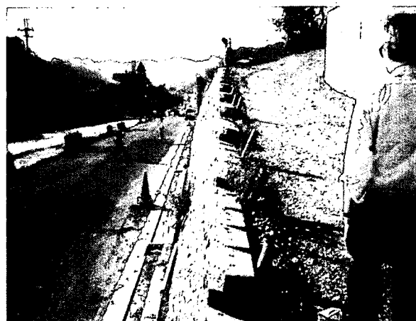
写真 3.5-⑫ 補強土壁の上面
