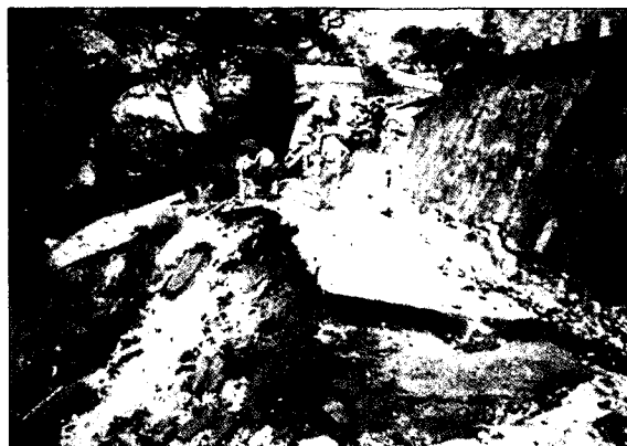
写真 3.2-⑨ 完全に崩壊した箇所の道路面の落込み
