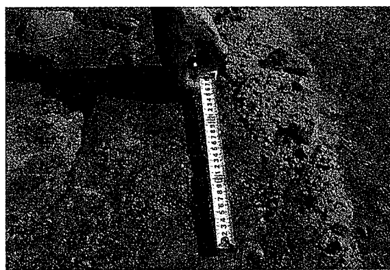
写真 3.7-④ 表面の細かいクラック
