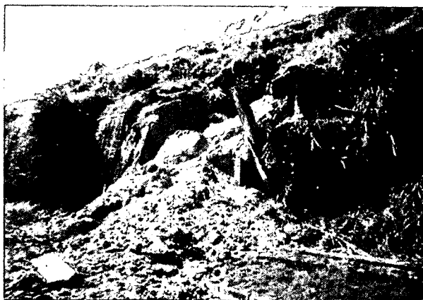
写真 3.4-③ 特に激しく破壊した下段部の状況 (崩壊部周辺は鉛直に近い勾配であった)
