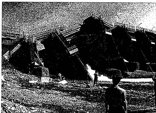
写真 3.1-⑧ ダム本体の被害状況
