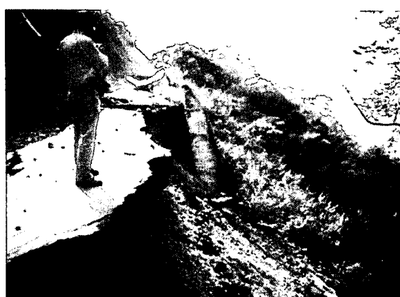
写真 3.2-⑪ アスファルトのオーバーレイ
