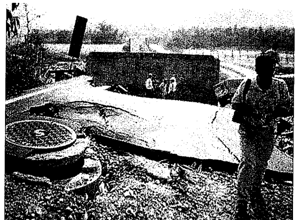
写真 3.3-⑤ 橋台背面盛土の沈下状況
