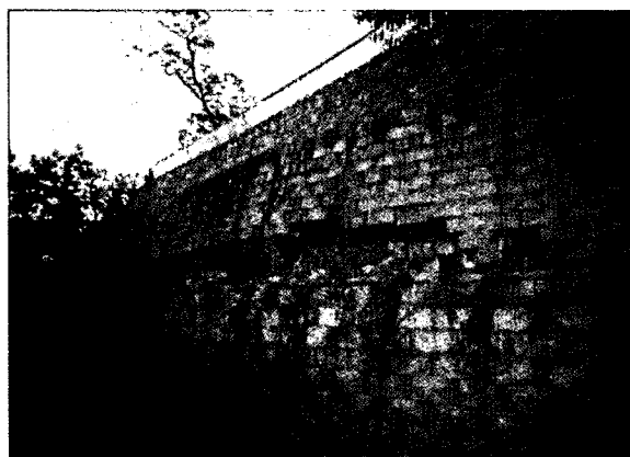
写真3.5-⑬ ブロックの抜け落ち状況
