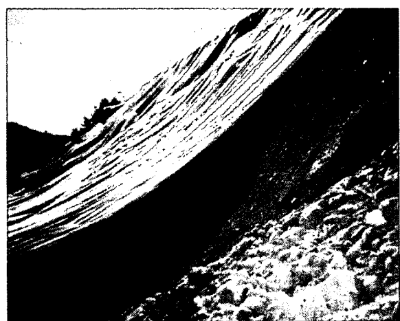
写真 3.4-⑧ 上層部のすべり面の状況
