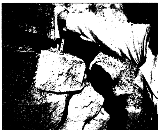
写真 3.5-⑤ ピン(L=15cm)による定着部
