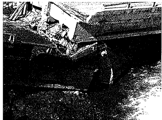
写真 3.1-⑤ 基礎底面らしき箇所が見られる
