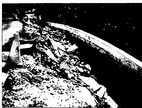
写真 3.2-④ 擁壁背面盛土の状況
