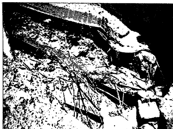
写真 3.4-④ 破壊した断面のジオグリッドの状況 (壁面側に向かって補強材が傾斜している)
