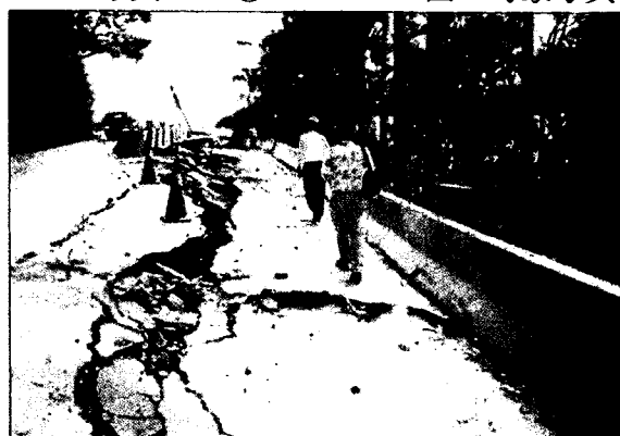
写真 3.3-②橋台に近接した区間の擁壁の破損 写真 3.3-③スケッチ箇所の盛土の変形状況
