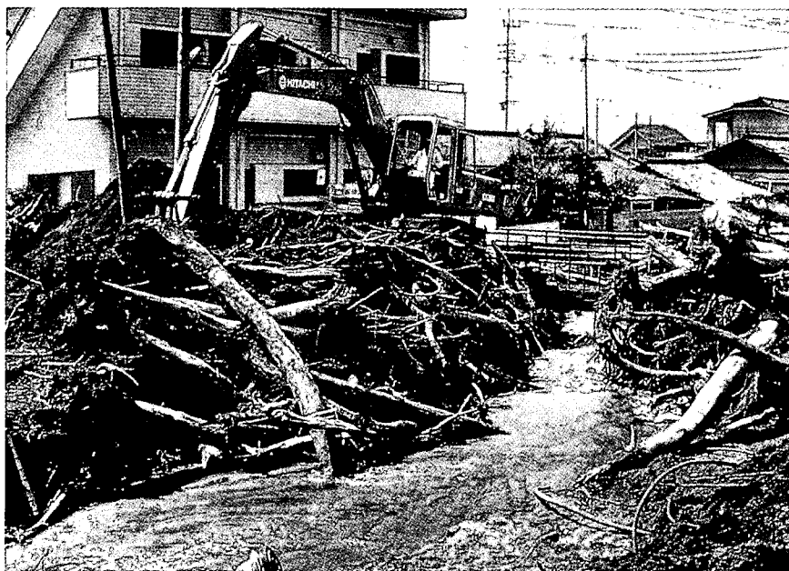
写真-6 93夏鹿児島風水害より
