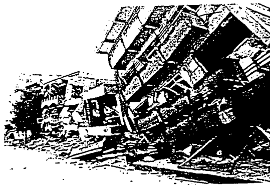
写真 3. 3. 2 非液状化領域での建物上屋の被害
