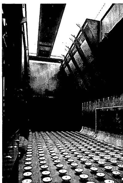
写真－1 硝化促進型循環変法（ペガサス）の設備
