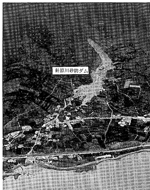
写真-4.3 H9.7.10 鹿児島県出水市針原川で発生した土石流
