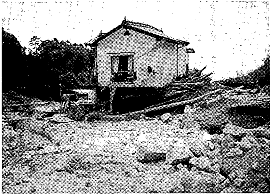
写真-4.4 流木による家屋の破壊（死者1名）
