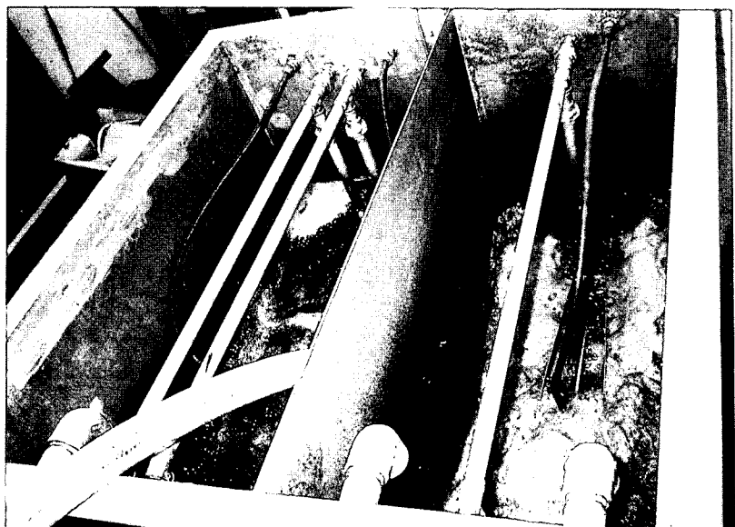
写真-7.4 膜処理装置内部
