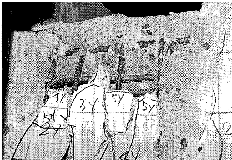
写真-3.9 帯鉄筋により軸方向鉄筋の座屈が抑えられた状態 ( 8\delta_{y0} )
