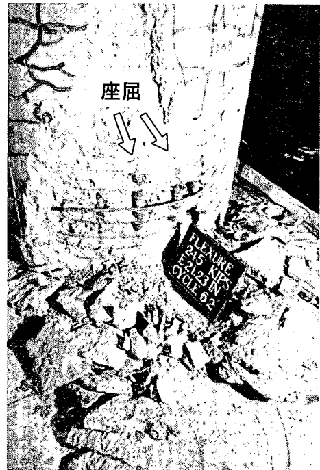
(b)軸方向鉄筋座屈時損傷写真
