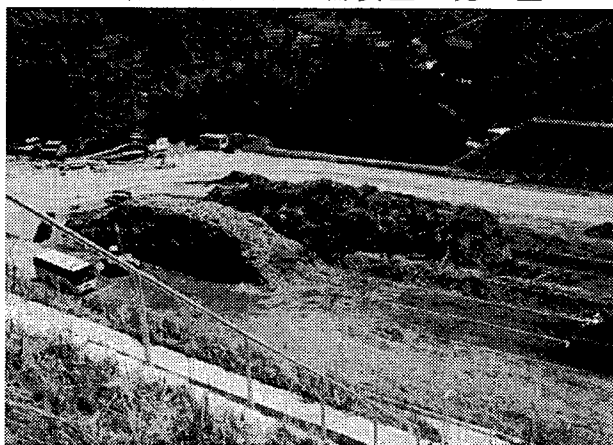
写真-1 第2東名高速道路建設現場での野積みによる堆肥化の状況
