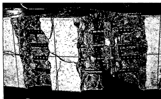
写真-1 梁中央部の破壊状況
