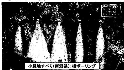
写真-1 集水パイプへのスライム付着状況
