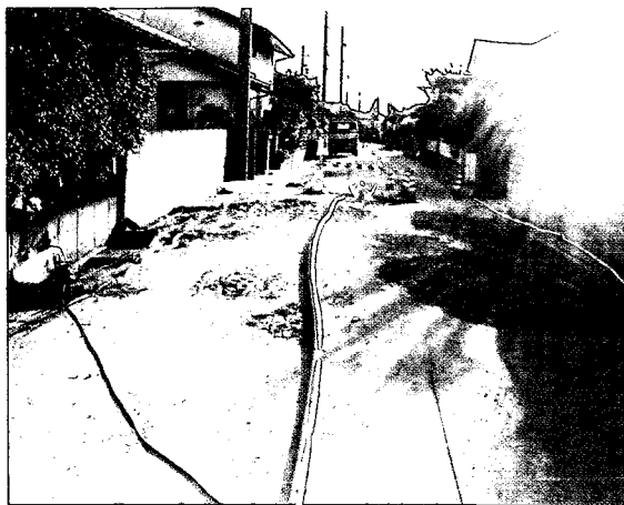
写真-9・27 管渠の敷設替え現場近傍の道路の状況
