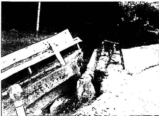
写真-6・39 コンクリート橋台 やや川側の傾いている
