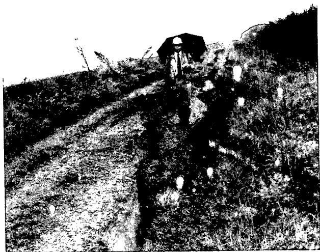
写真-7.1 弓浜干拓地 中海側堤防天端の状況
