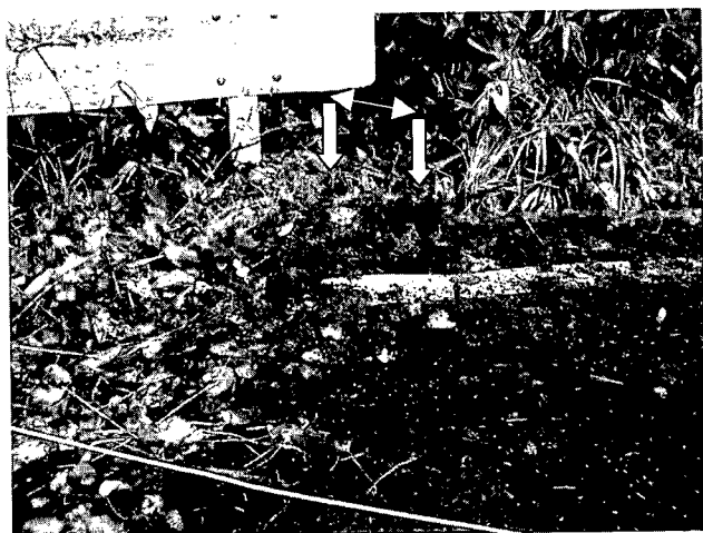
写真-3-18 側溝への路面の乗り上げ (④)
