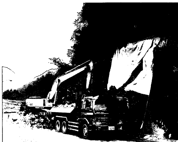
写真-6・55 石積擁壁の崩壊
