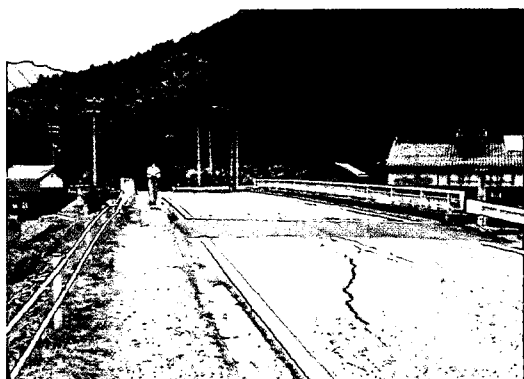
写真-6・6 中菅橋全景 取付部をオーバーレイして いる
