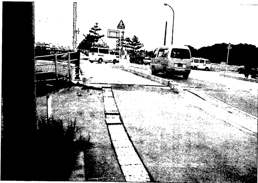
写真-5・3 液状化による流動化に起因する取り付け部の沈下
