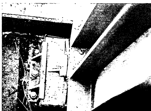
写真-6・34 擦過痕のある可動支承部 (南大山大橋)
