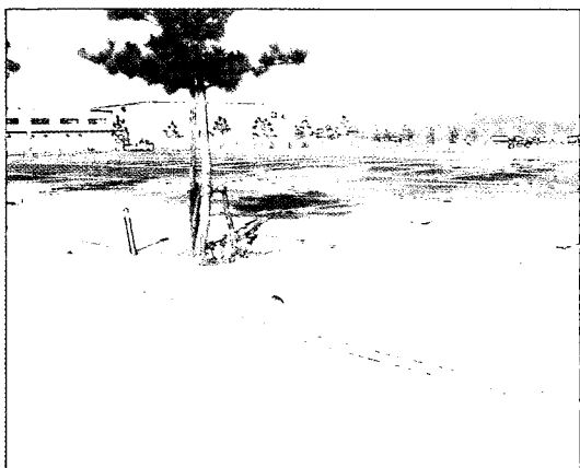
写真-9・2 竹内団地地区污水枝線周辺部 (駐車場が広範囲にわたり噴砂で覆われている。)
