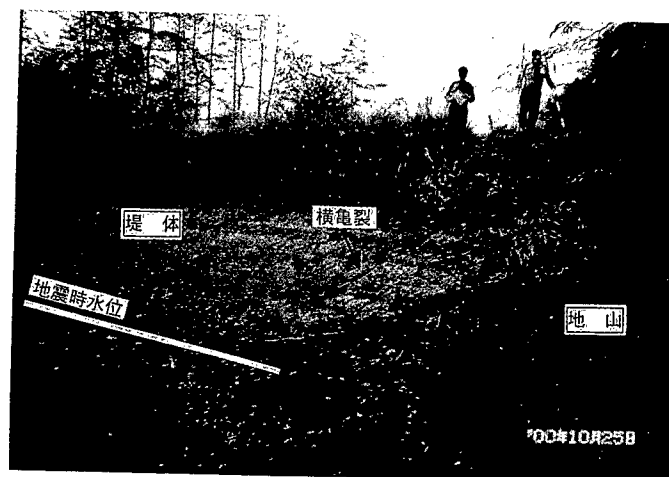
写真-7・19 絹さこ池（西伯町）の右岸寄り上流面の横亀裂
