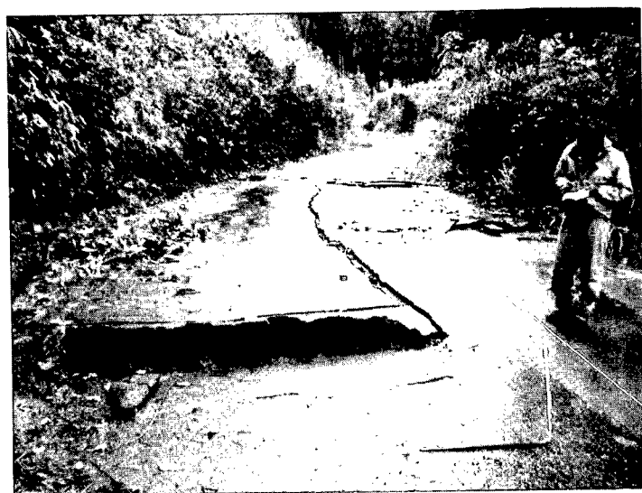
写真-3-15 路面の圧縮亀裂（図-3-18の①，以下同じ）
