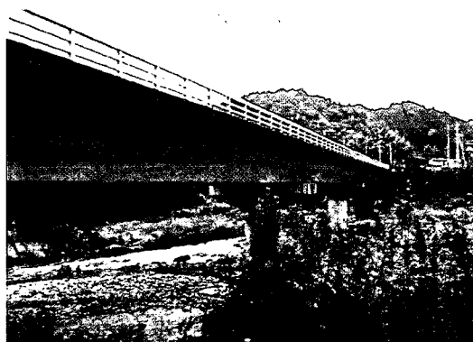
写真-6・8 乗越橋全景
