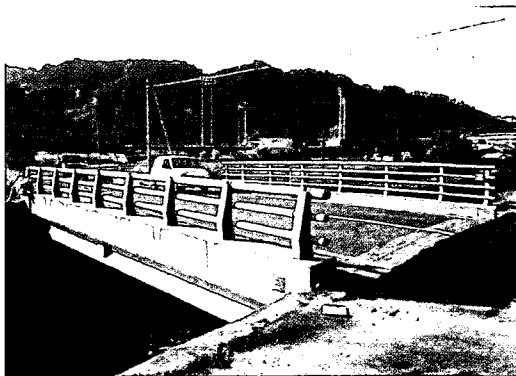
写真-6・23 新浅井橋全景 段差の補修をしている
