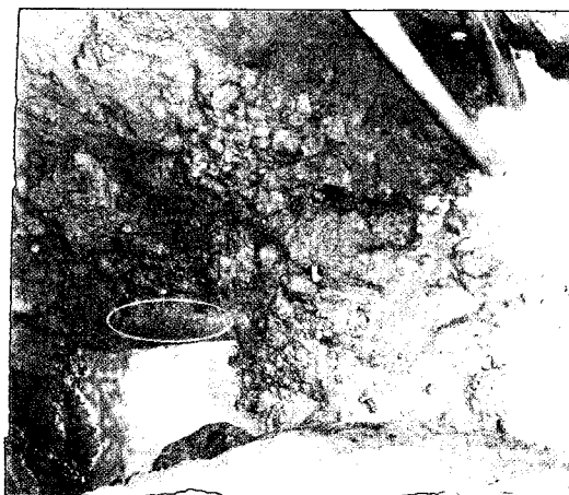
写真-9・28 管渠の縦断方向に発生していたクラック (写真黄色囲みにクラック)
