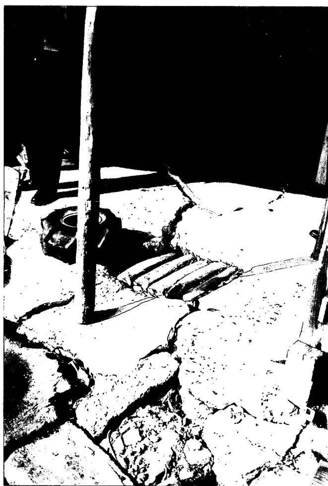
写真-8・23 日野町下黒坂：人家の車庫内に生じたクラック（2000年11月27日撮影）
