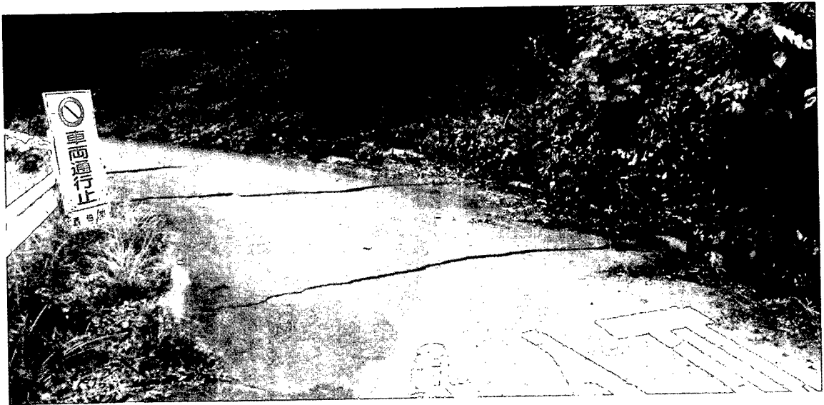
写真-3・4 路面の亀裂（図-3・14 の④）
