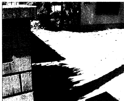
写真-9・10 段差周辺部の噴砂跡
