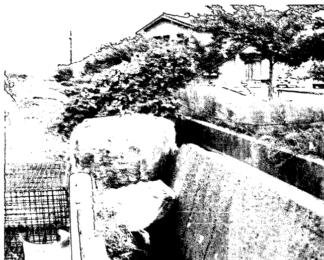
写真-6・51 道路反対側まで達した落石
