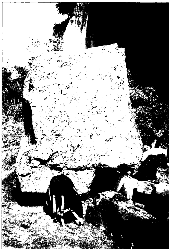
写真-8・11 日野町根雨：斜面下部の擁壁 付近に達した落石 径約2mの結晶片岩（三郡変成岩類 の塩基性片岩）。
