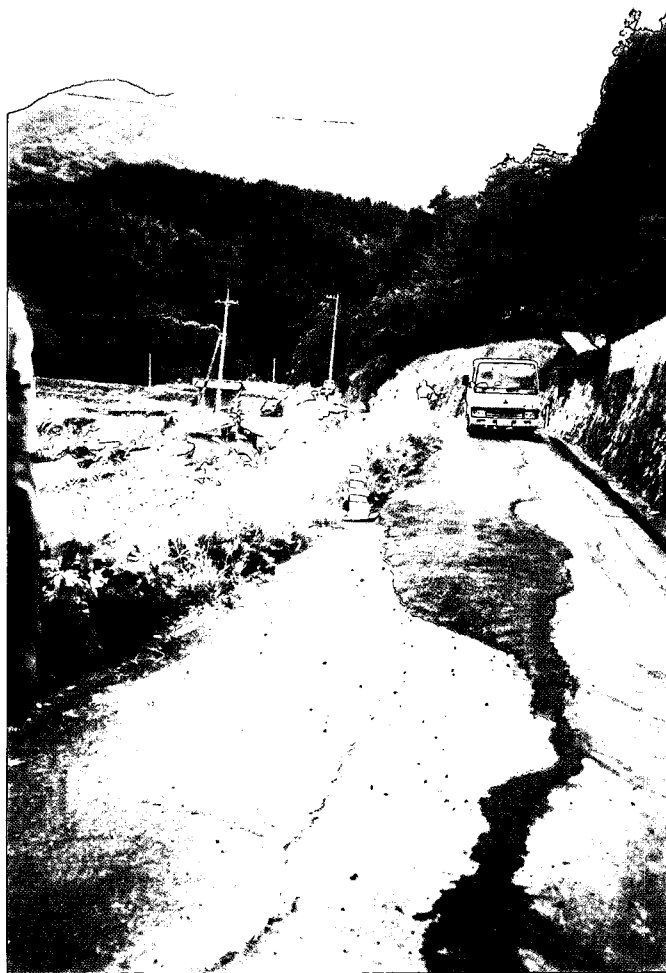
写真-8・17 日野町榎市：道路に生じたクラックの応急補修跡
