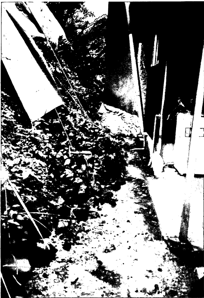
写真-8・25 伯太町須山①：人家裏の小崩落
