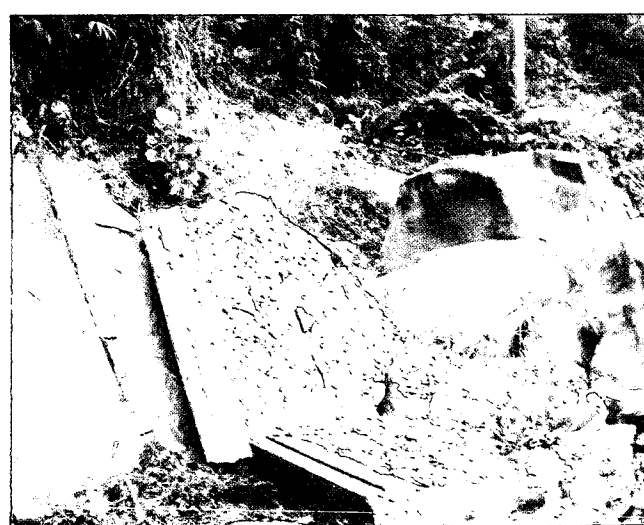
写真-6・52 土留壁の被害状況
