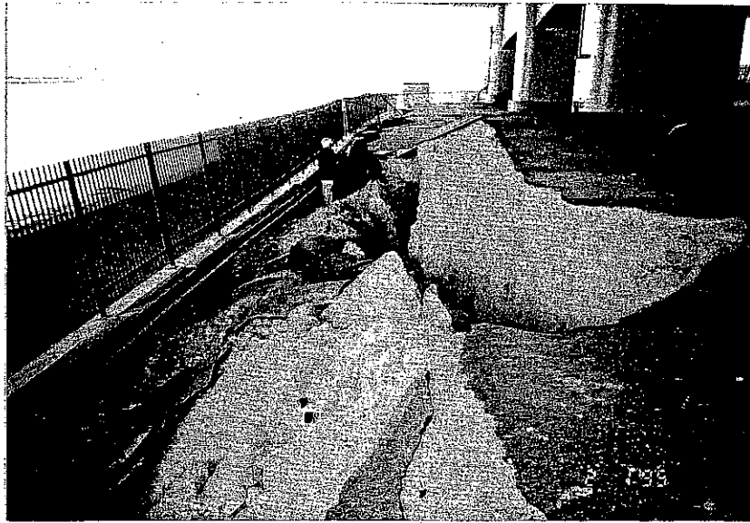
写真-1.1 新夙川橋近傍の地盤の変状 1)
