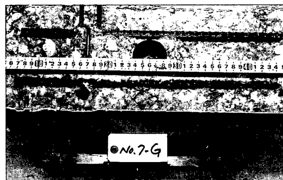
写真-16 鋼材の腐食状況 (B2 : No. 7)
