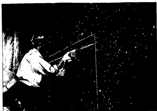
写真－2.1 鉄筋探査状況
