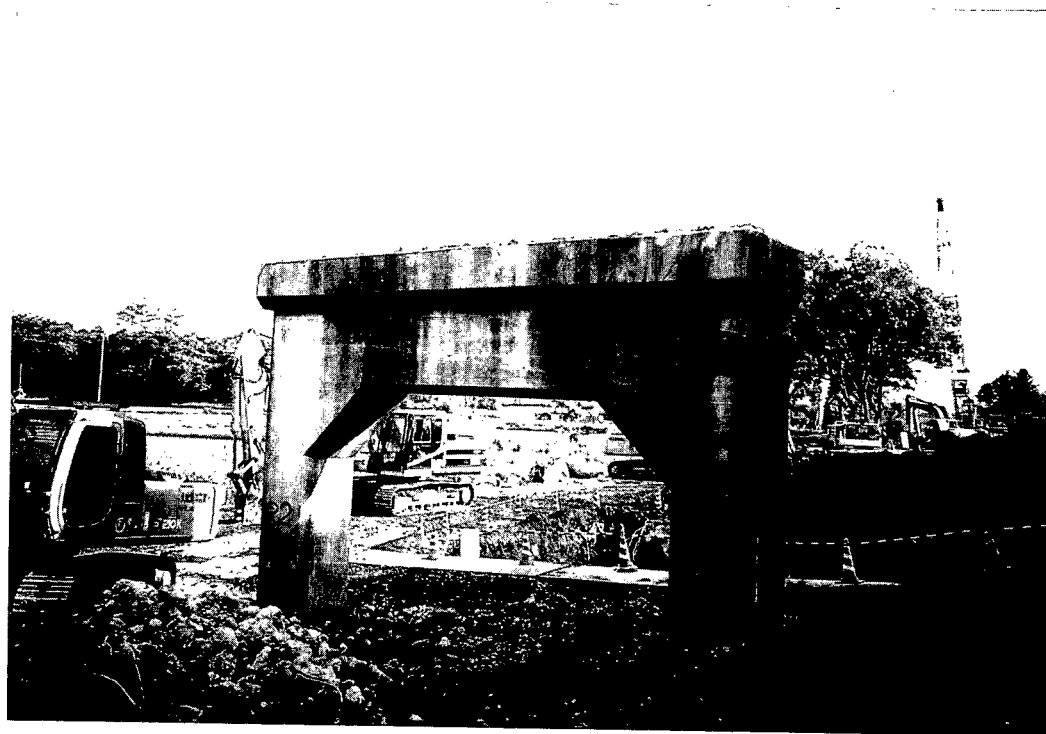
写真-1.1 旧榊橋P2橋脚
