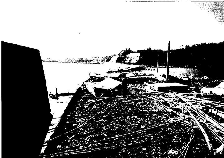
写真－２． ９ 手場海岸の潮止堤の倒壊
