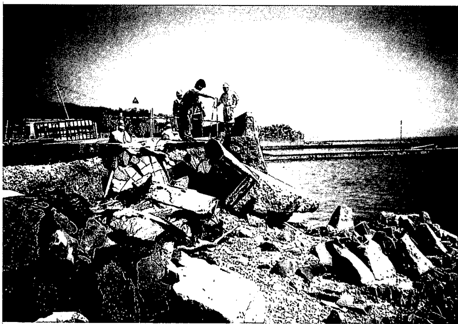
写真－２．８ 被災した松合地区の護岸の状況
