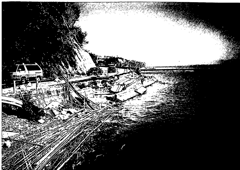
写真－２．７ 松合地区の護岸の被災
