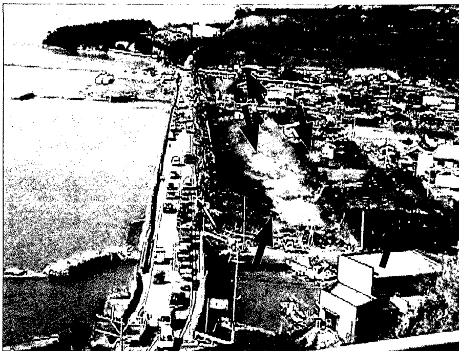
写真－２．１ 松合地区の全景（矢印は海水の浸入方向）
