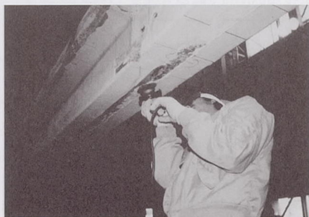
写真-4.2 桁下面の塗膜除去
