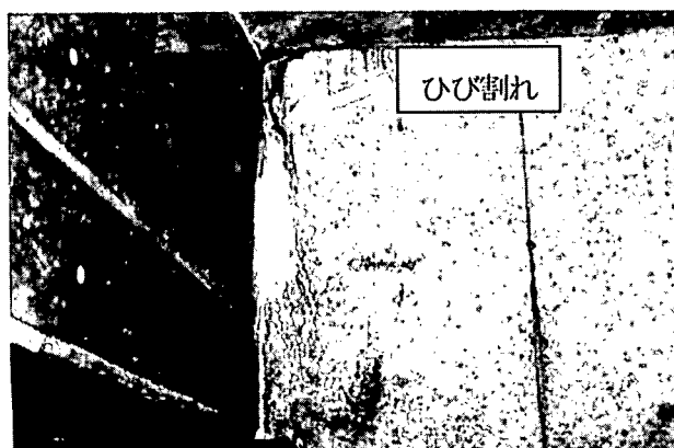
写真-3.2.5 横桁のひび割れと遊離石灰(損傷度Ⅱ) 〔ホーストンT桁, 対策区分C-II, 1987年竣工〕
