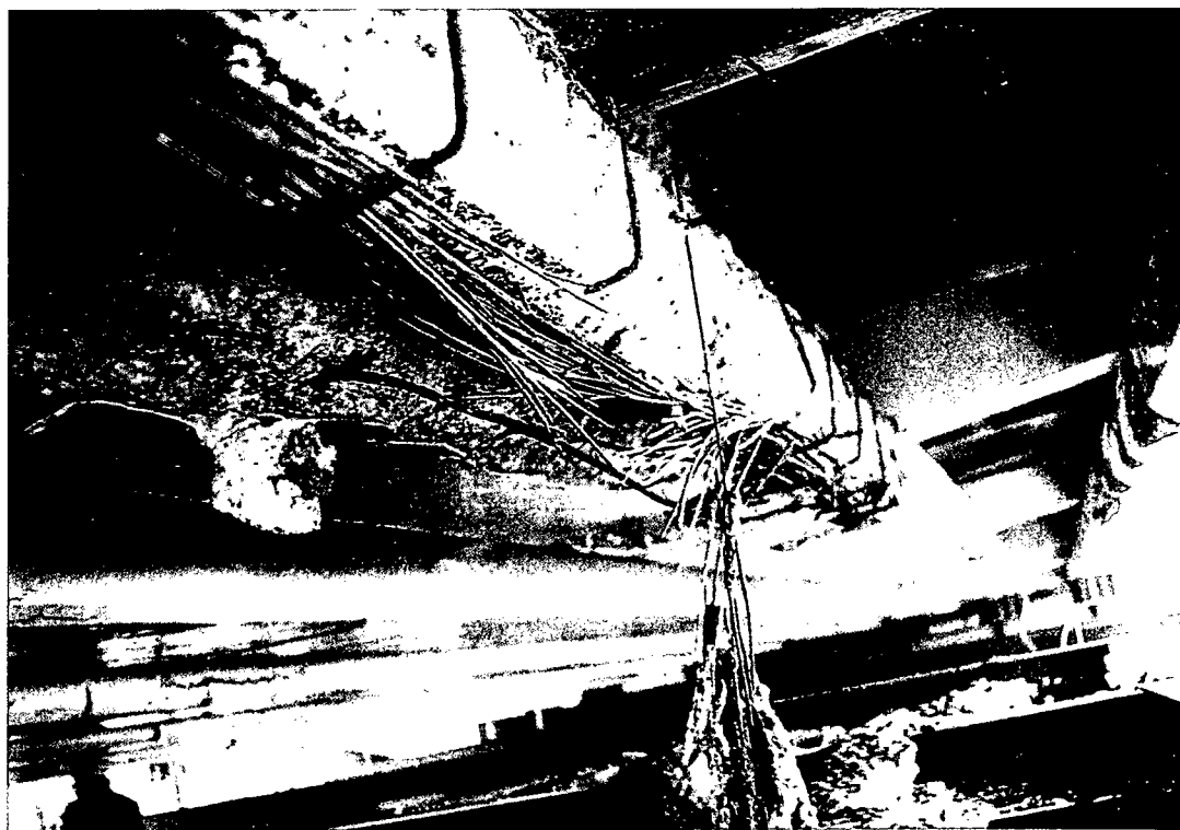
⑤主桁のPC鋼線破断 (H3. 7月)
