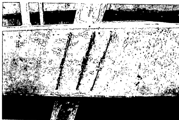
写真-3.2.4 主桁下面の鉄筋露出(損傷度Ⅱ) 〔ホーストン桁、対策区分B-III、1986年竣工〕
