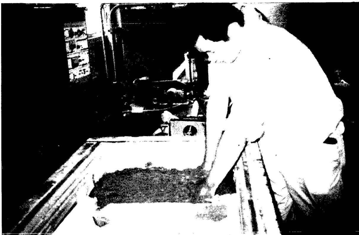
写真-2.13 高含水口ム詰め込み状況
