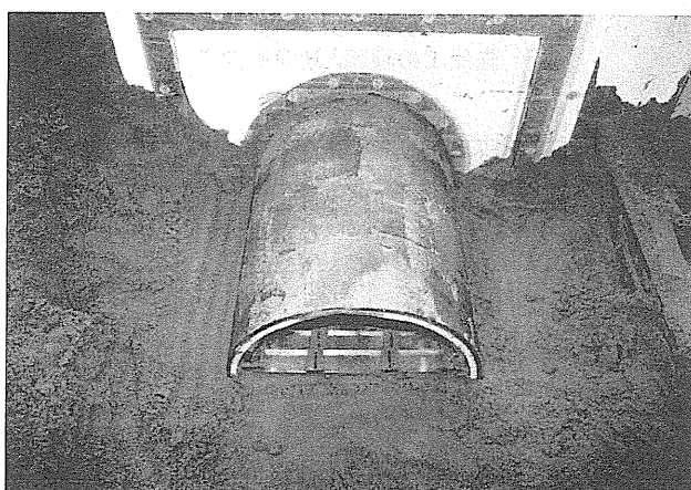
写真－2.8 実験後のトンネル設置状況 （シェルタイプ）
