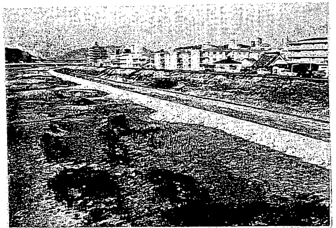
写真-3 設置後された緊急用河川敷道路
