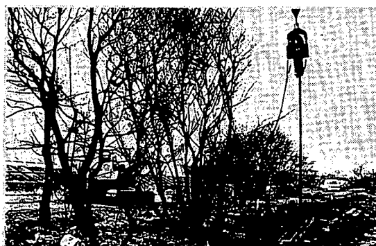
写真-4 ヤナギ越しに行っているシートパイルの打設
