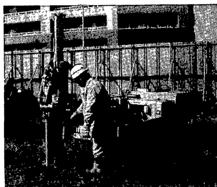
写真-5.6.1 小型ボーリングマシンによる施工状況
