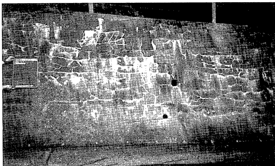
写真-4 アルカリ骨材反応の事例
