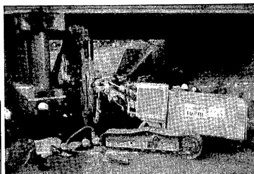
写真-5.8.1 施工状況
