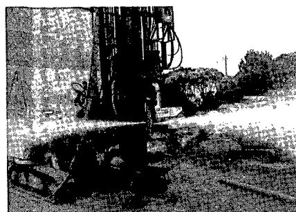
高圧噴射状況
