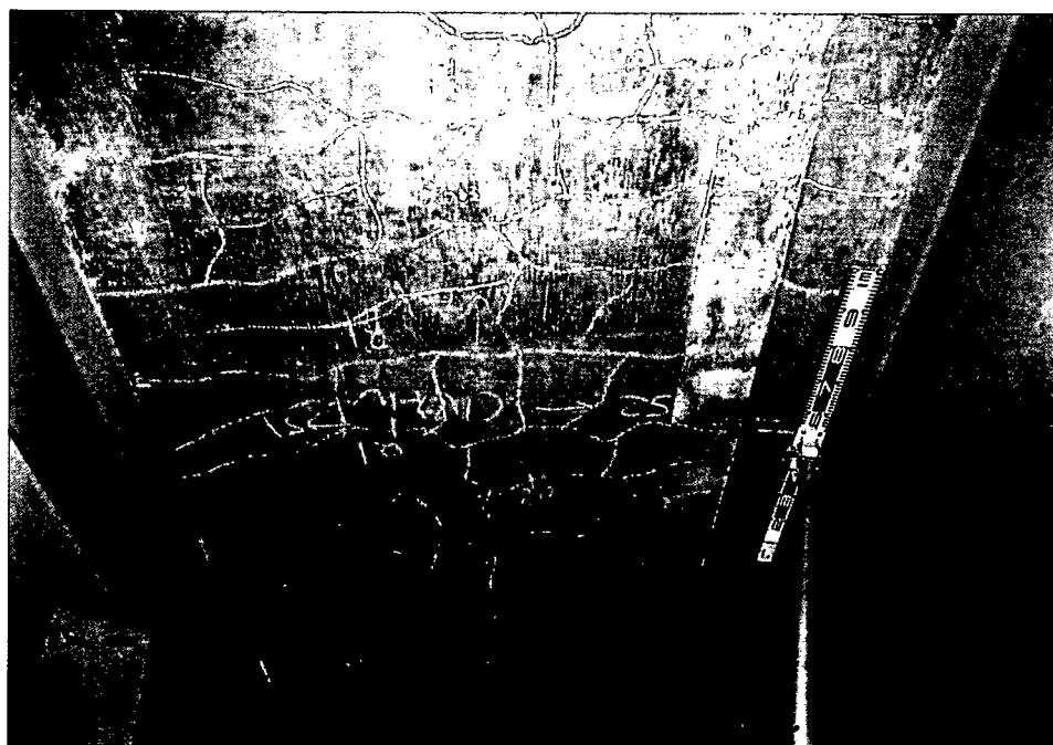
写真－2.10 劣化度Ⅱの事例(床版のひび割れ, 橋梁上部構造) ※繰返し荷重の影響で床版にひび割れが生じていると考えられる事例。
