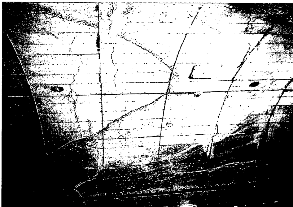
写真－2.9 劣化度Ⅲの事例(コンクリートの流動跡, トンネル) ※トンネルのアーチクラウン(写真ほぼ中央)からスプリングライン付近にかけて、 打設時にコンクリートが流動した跡が明瞭に見られる事例。場所によってはコー ルドジョイントとなり比較的大きなひび割れが生じており、劣化度Ⅲと判定され た。
