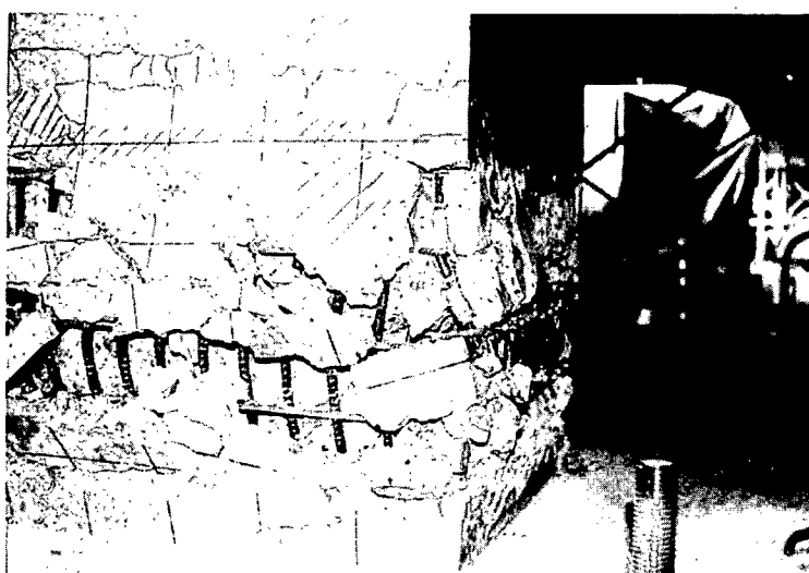
写真-5.6 最終損傷状況 (PB角)
