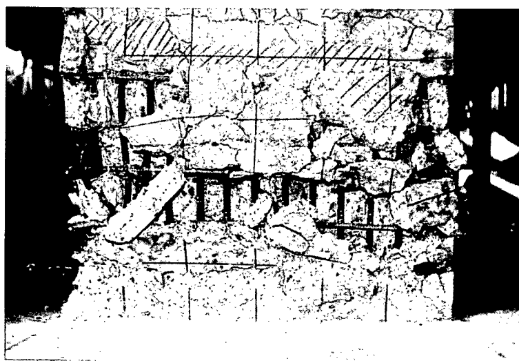
写真-5.7 最終損傷状況 (B面)
