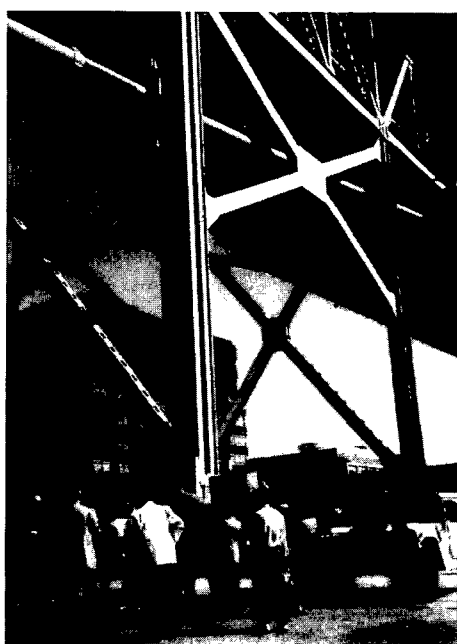
写真－１ サンフランシスコ・オークランド・ベイブリッジ西側アンカレイジ現場（鋼製橋脚の耐震対策：すべり免震支承の設置、ブレース材の新規添接、橋脚基部のアンカー設置、メインケーブルとのゴム製バンパーの設置）
