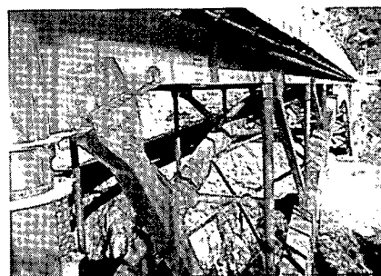
(b) ゲルバーヒンジ部の損傷状況
