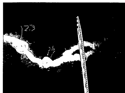
写真-2.3.6 シール材の残存事例
