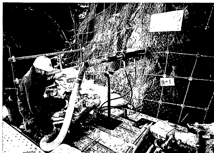
写真4-1 ボーリング孔を用いた圧入法による試験状況
