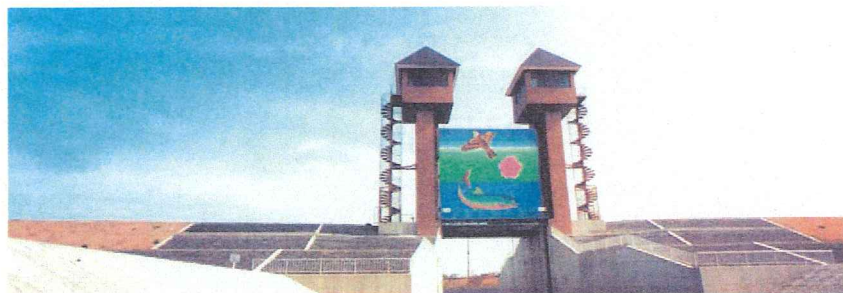
写真－５．５ 扉体への描画の事例３
