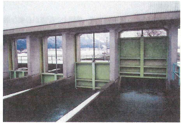
写真-7. 2 FRPの扉体への適用例
