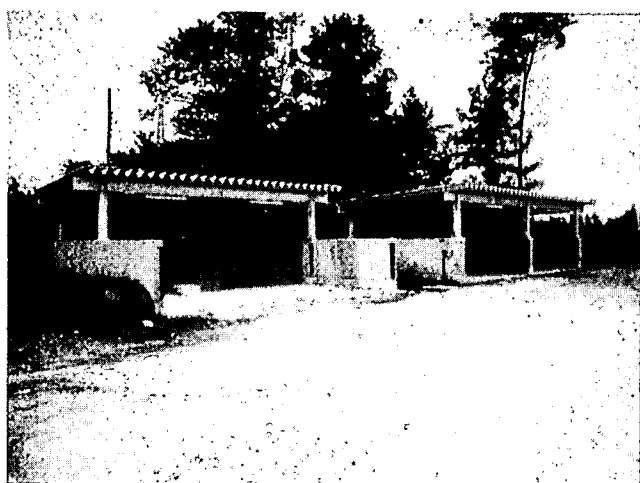
写真－4 屋外ストックヤード
