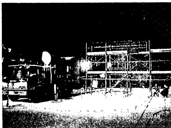
写真-7 風速測定状況
