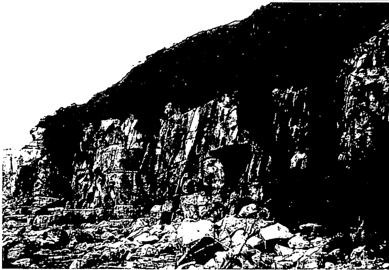
a) 規則的な亀裂：和歌山県周参見町
