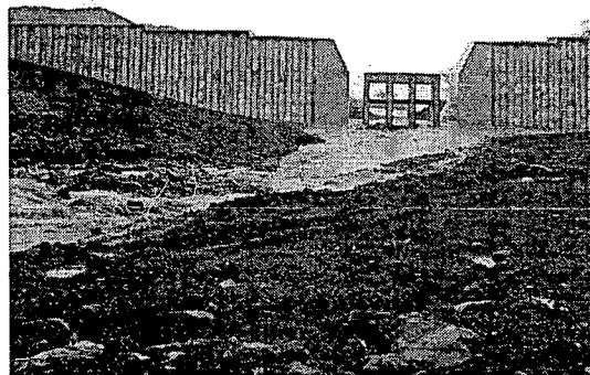
カニガ沢における出水状況 2002 年 6 月 18 日
