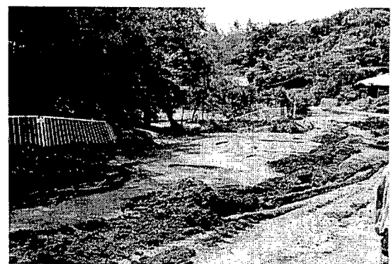
泥流による被害 2000年7月31日
