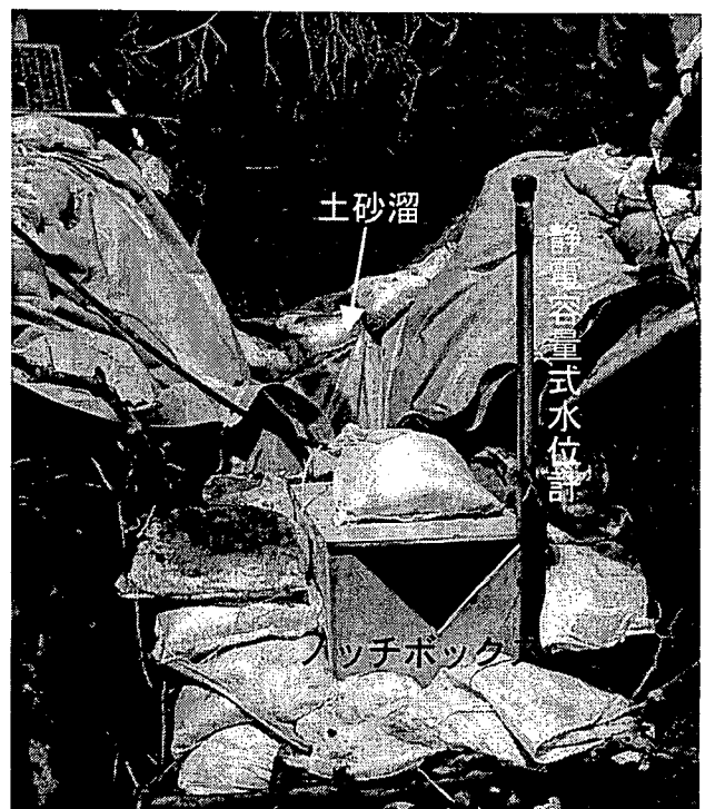
写真-7.1 量水堰等の設置例 (SU, 2002年3月)
