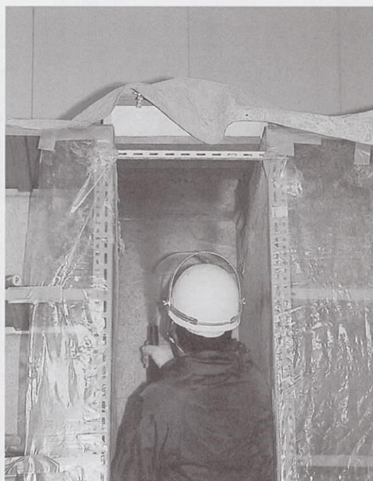
写真-1 逆打ち-吹付けの状況
