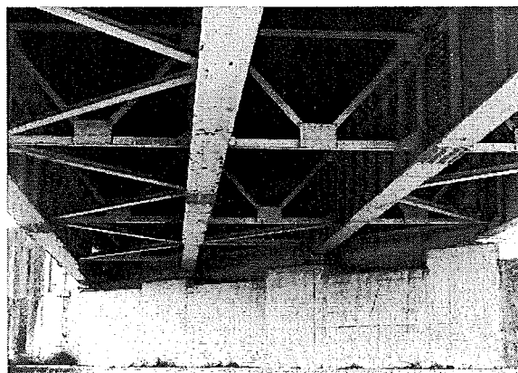
(b) 桁下の状況
