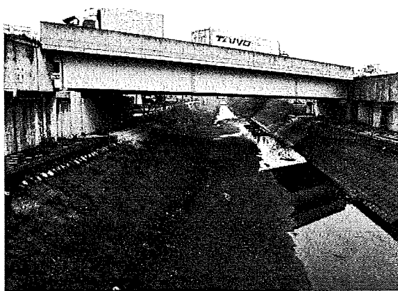
(a) 橋梁全景
