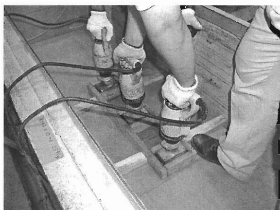
写真-2.8 支持地盤の締固め状況
