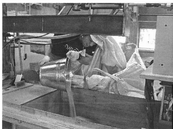
写真-2.9 根入れ部への砂の投入
