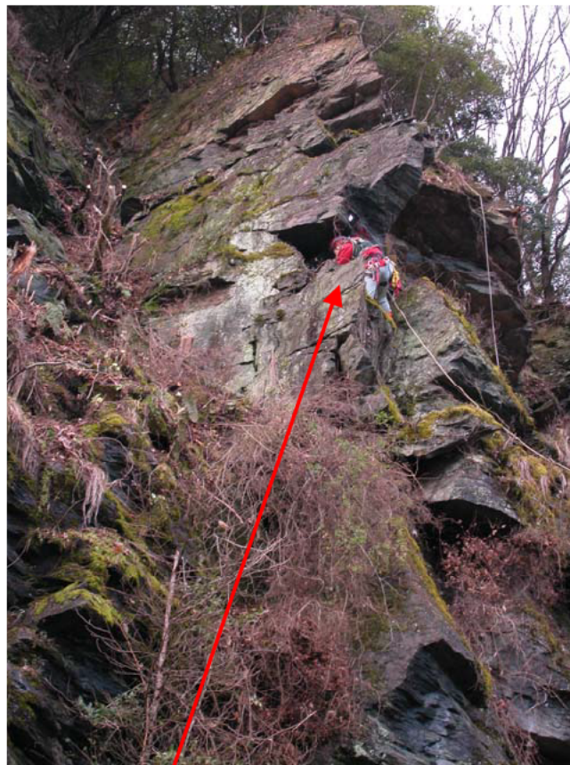
計測点P-6設置ブロック (側面)
