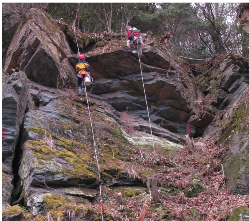
写真－3.3.2 ロッククライミングによる振動計の設置作業の事例 (小型軽量の機種であれば足場がなくても設置可能)
