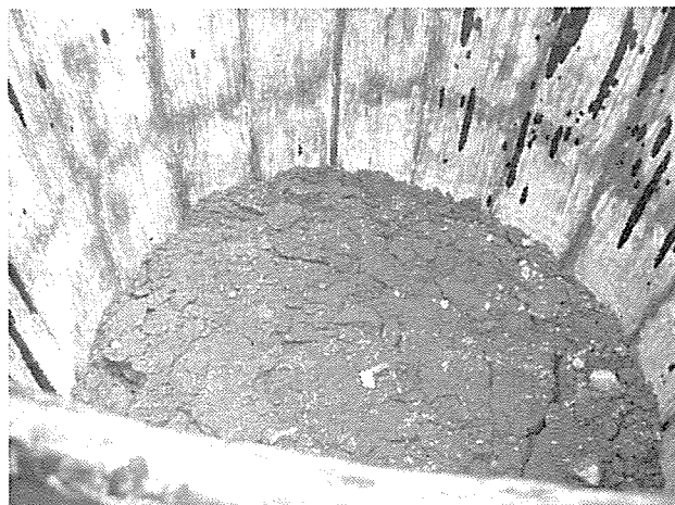
写真-付IV.4 外側ケーシング建込み後の内部地盤
