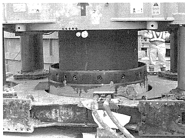
写真-付IV.7 内側ケーシング建込み時
