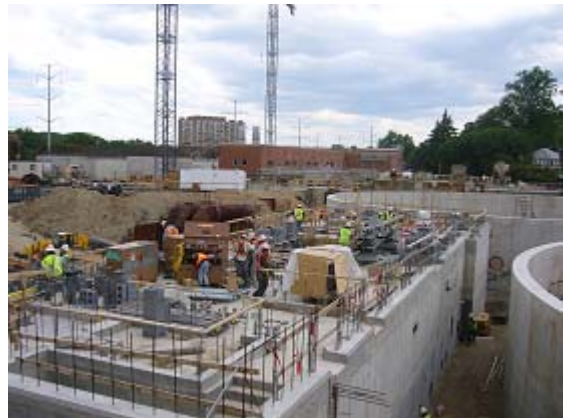
写真—5 下水処理施設建設現場
