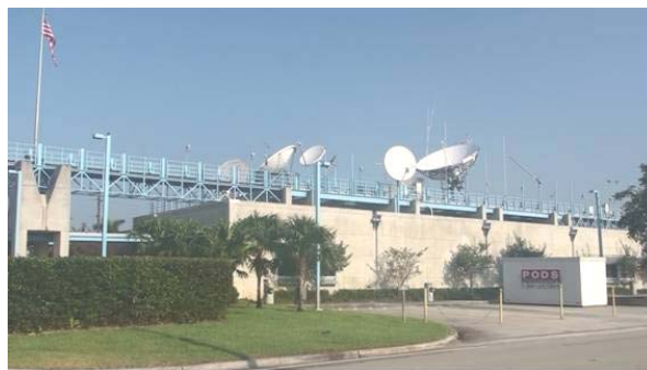
写真一20 海洋大気庁国立ハリケーンセンター
