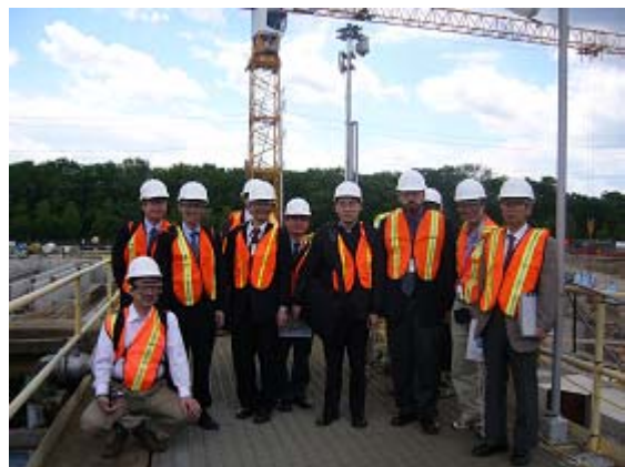
写真—6 下水処理施設建設現場にて
