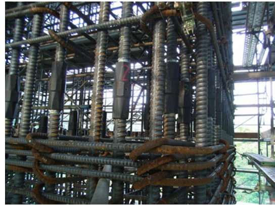
写真-2.10 機械式継手の施工例
