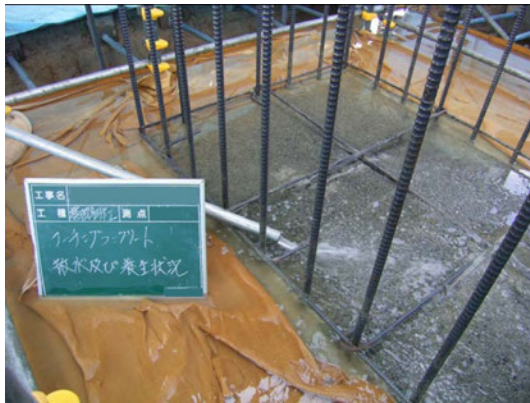
写真-5.18 九州 A：湛水養生状況
