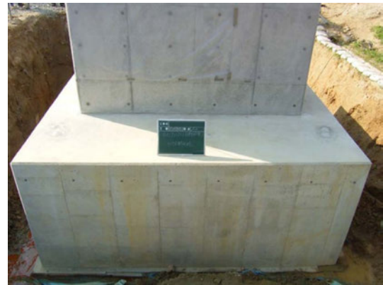
写真-5.19 九州 A：フーチング外観
