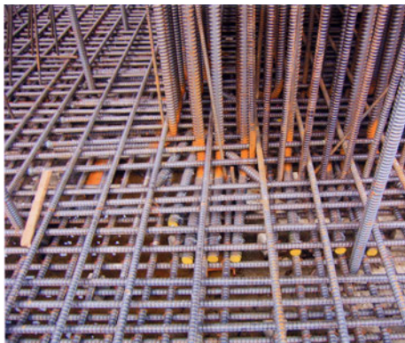
写真-2.4 橋脚柱の軸方向鉄筋 (D51) の定着 写真-2.5 橋脚柱の鉄筋と杭頭補強鉄筋の干渉
