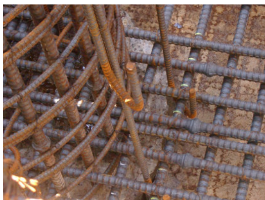
写真-2.1 杭頭補強鉄筋とフーチング鉄筋の干渉 写真-2.2 溶接による杭頭外周鉄筋の施工状況
