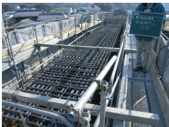
(1) ラーメン橋脚梁上面の配筋状況
