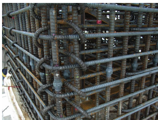
写真-2.6 橋脚柱鉄筋状況
