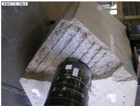
写真-5.9 Case G：試験終了時の杭とフーチング 接合部の損傷状況
