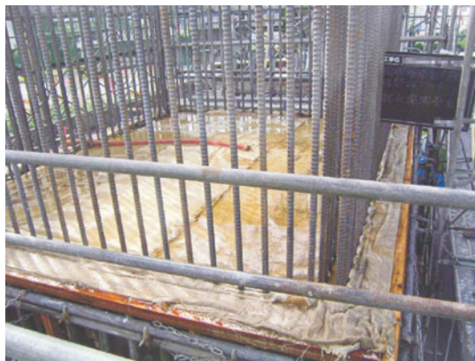
写真-2.11 フーチングコンクリート湛水養生
