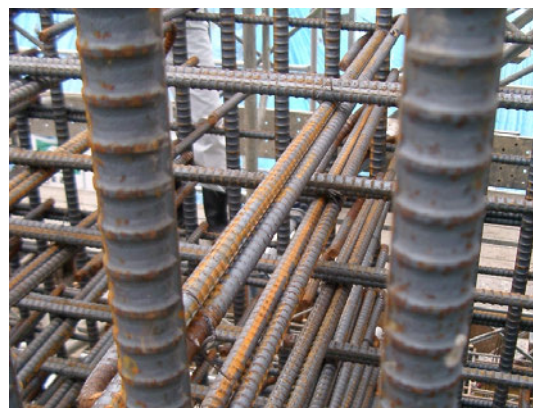
写真-2.7 中間帯鉄筋の配置
