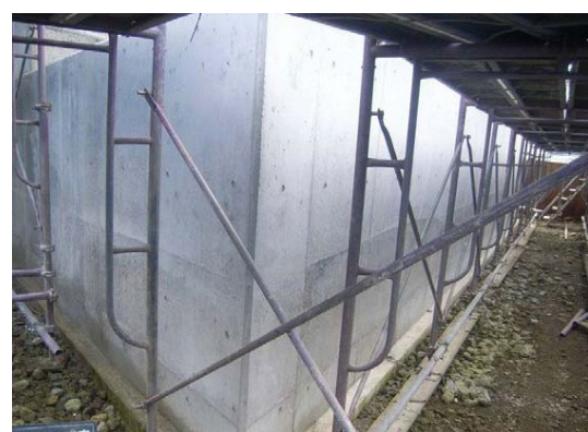
写真-5.12 東北 A：フーチング施工完了
