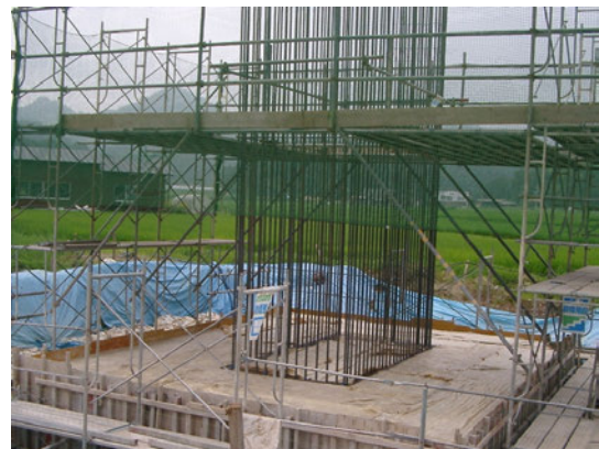
写真-2.12 フーチングコンクリート湿潤養生
