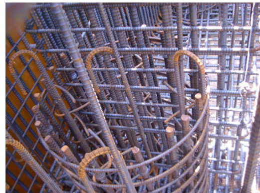
写真-2.4 橋脚柱の軸方向鉄筋 (D51) の定着 写真-2.5 橋脚柱の鉄筋と杭頭補強鉄筋の干渉
