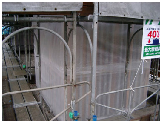
写真-2.13 柱部のシート巻きによる養生 (型枠脱枠前)
