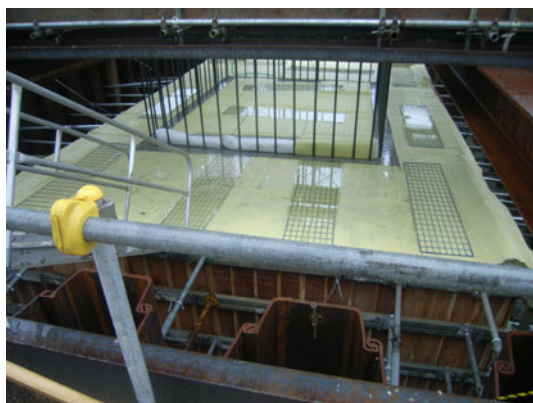
写真-5.16 近畿 B：養生状況
