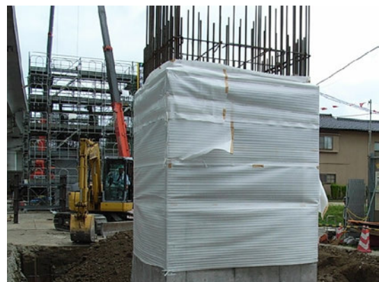
写真-2.14 柱部のシート巻きによる養生 (型枠脱枠後)
