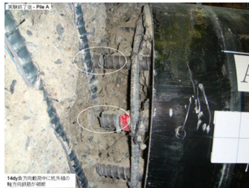
写真-5.10 Case G：試験終了時の杭頭補強筋の破断状況
