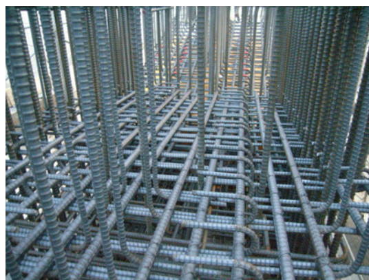
(2) ラーメン橋脚の梁と柱の接合部
