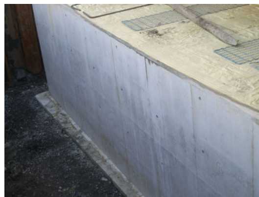
写真-5.17 近畿 B：フーチング外観
