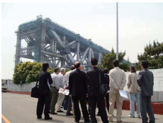
写真-1 東京港臨海道路橋のメイントラス 組み立て現場
