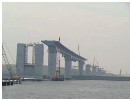
写真-2 東京港臨海道路橋の海上部の施工 状況
