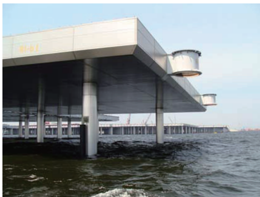
写真-3 羽田空港の新滑走路建設状況
